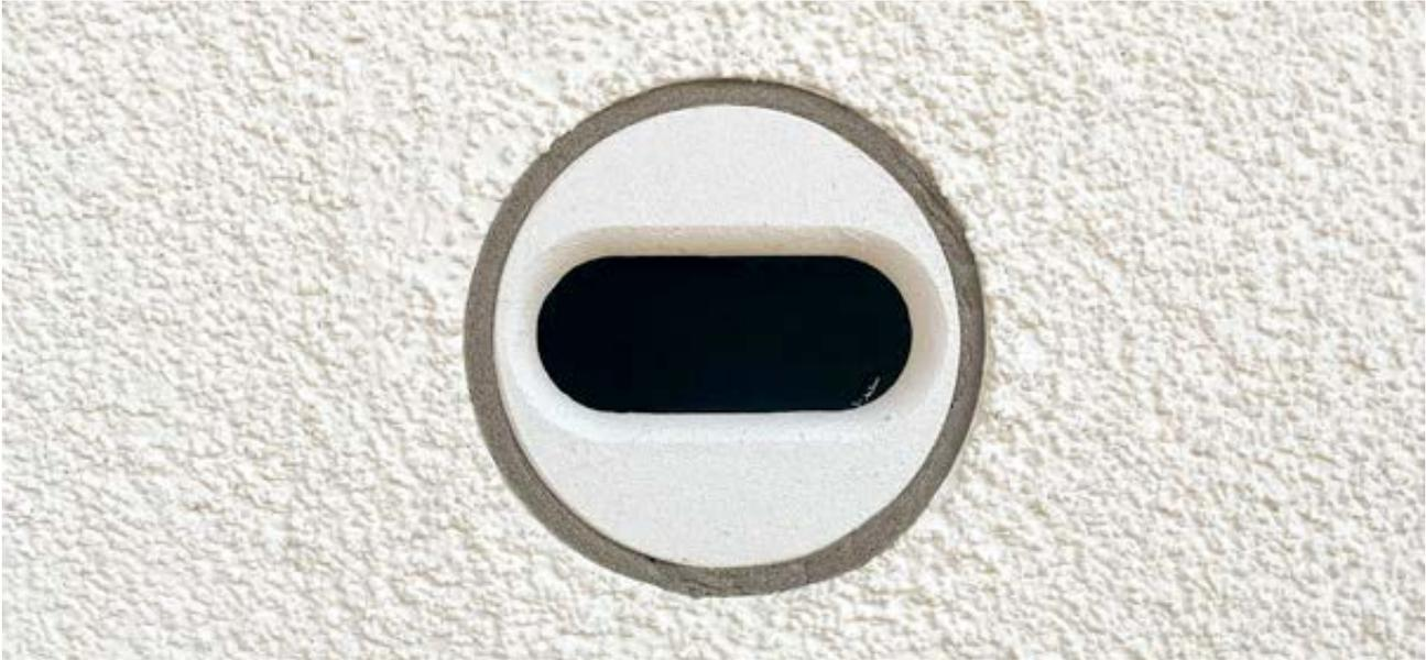
*In Wärmedämmverbundsystem (WDVS) eingelassener Nistkasten für Mauersegler*
